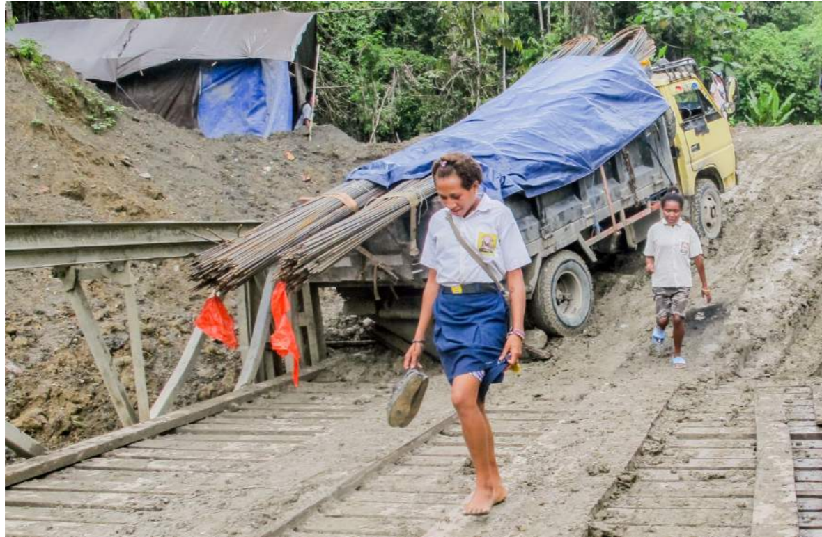
Jalan rusak menuju Kampung Senggi, Keerom
